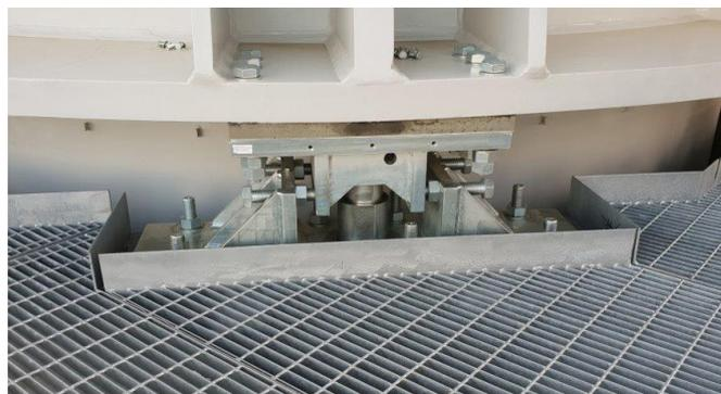
Las células de carga PR 6201 pesan con precisión cargas de hasta 12 toneladas.
